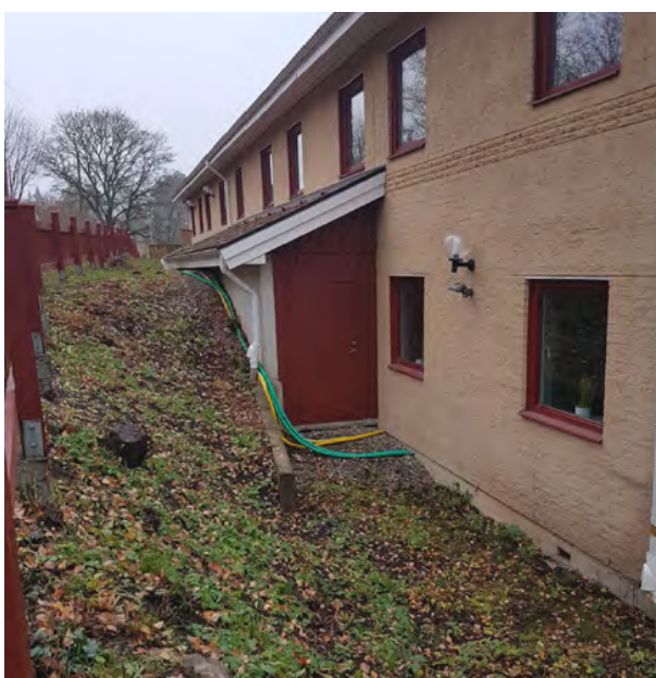
Byggnadens baksida med utstickande byggnadsdelar som når ända fram till fast berg.
